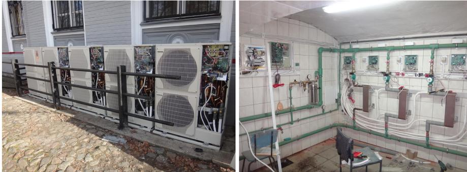
На фото представлен каскад тепловых насосов Mitsubishi. Суммарная отопительная мощность 70 кВт, отапливаемая площадь 1000 кв. метров. Оборудование установлено в здании одного из ж/д вокзалов Калининградской области.
