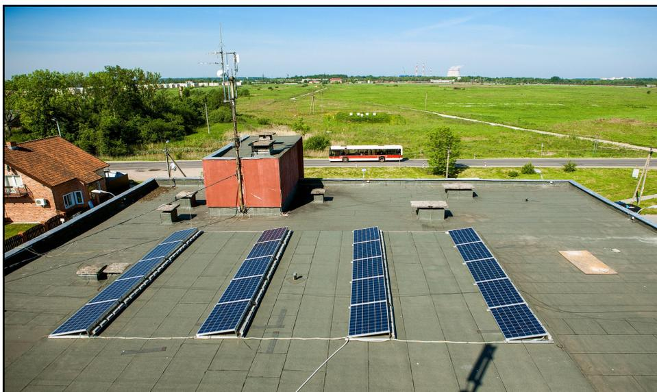
Солнечная электростанция мощностью 5 кВт/час, с интеллектуальной системой освещения на светодиодных светильниках. Установлена в здании администрации Луговского сельского поселения Калининградской обл. Основное назначение – питание системы наружного освещения.
