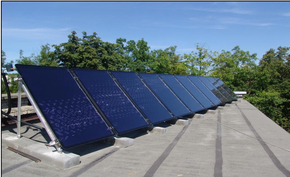
Установка для приготовления горячей воды. Расположена в детском саду г. Светлый, Калининградская область. Суммарная тепловая мощность 22 кВт, емкость теплоаккумуляторов 2 м. куб. Производительность горячей воды 15 л./мин.
