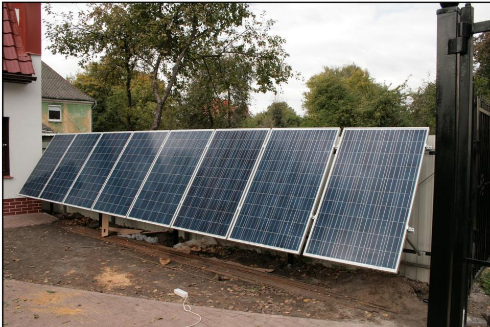
Частный дом, мощность 2кВт/час, используется как дополнительный источник электроэнергии. Работает совместно с сетью общего пользования.
