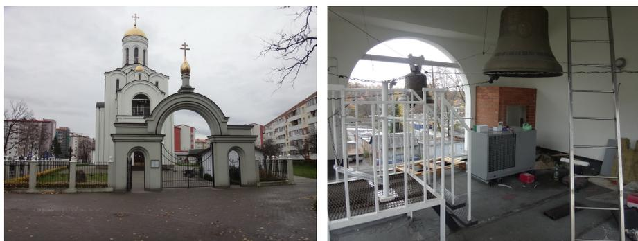
На фото: воздушный тепловой насос, установленный в храме. Мощность этого теплового насоса 16 кВт, отапливаемая площадь 320 кв. метров.
