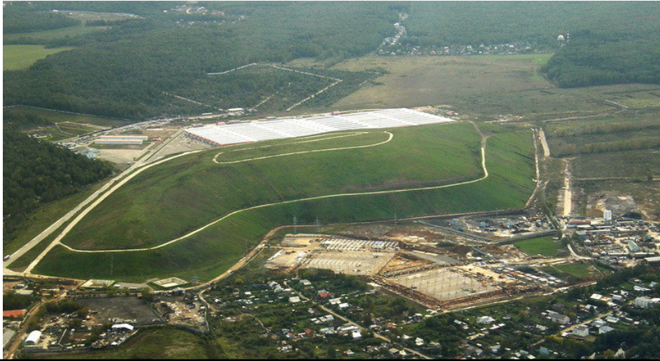
Пример рекультивированного полигона (г. Химки, Московская область) Beispiel einer sanierten Deponie (Chimki, Gebiet Moskau)
