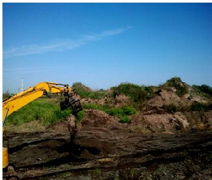
Nach der Abnahme der oberen Schicht aus Asche und Baumrinde wird die Fläche geflutet. Zur vollständigen Feuerlöschung sowie zur Verhinderung des erneuten Brandes wird die Baumrinde umgegraben, mit Wasser erneut geflutet und verfestigt. Nach Abschluss der Arbeiten entsteht eine ebene befestigte Fläche.
