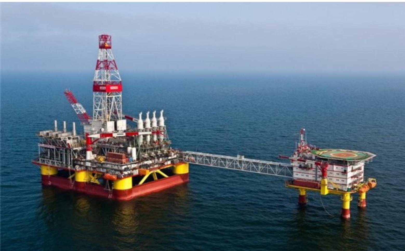
На морской ледостойкой стационарной платформе Д-6 и самоподъемной плавучей буровой установке «Арктическая» применяется принцип «нулевого сброса»
